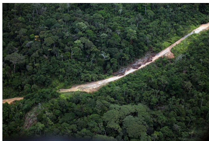
Vía recientemente abierta por maquinaria pesada hacia la comunidad de Ipiak.
